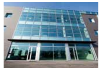
La sede di In Job a Mantova
